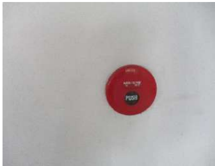
ภาพที่ 2.3-34 อุปกรณ์แจ้งเหตุด้วยมือ
