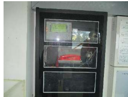
ภาพที่ 2.3-35 ตู้ควบคุมระบบแจ้งเหตุเพลิงไหม้
