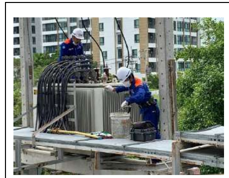
ภาพที่ 2.3-19 เจ้าหน้าที่ดูแลและซ่อมบำรุงหม้อแปลงไฟฟ้าโครงการ
